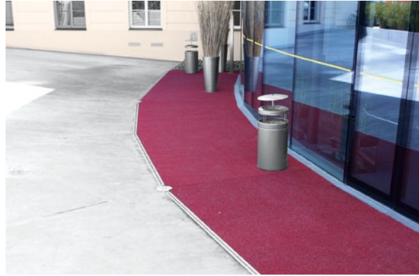
Landestheater Linz: randverstärkte Edelstahl-Doppelschlitzrinne, in Gehrung mit Eurosink V4A Bodenabläufen mit verschraubbarer 10 mm Sanitärabdeckplatte
