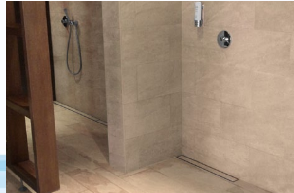
Zadar, Hotel Falkensteiner: Einzelduschrinnen in diversen Längen mit bis zu 3 Ablaufkörper, Abdeckung verfliesbar, mit bis zu 3 wandseitigen Hochzügen
