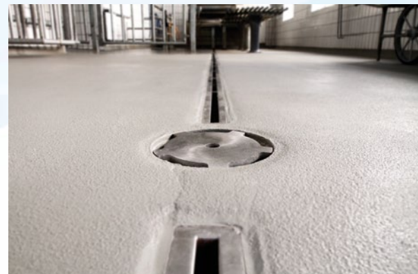
Schlachthof Laufen: Schlitzrinnen mit Randverstärkung aus Edelstahl-Vollmaterial, somit staplerbefahrbar, Industrieablauf mit Rinneanschlüssen, Massive Abdeckung Klasse M125
