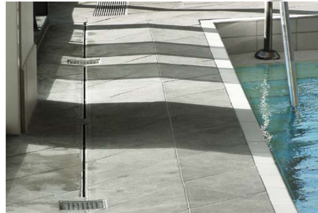
Parkbad Linz: Ebene Oberflächen, kaum sichtbare Entwässerung – perfektes Badeerlebnis
