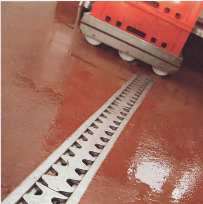
*Ideale Lösung: Die Kombirinne ist randverstärkt und selbst mit einem Stapler befahrbar.*
