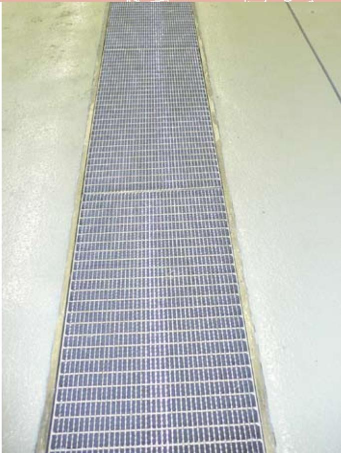
■ Die Kastenrinnen in Spezialausführung sind wie der Pumpensumpf und die Gitterroste aus Edelstahl (1.4571) gefertigt. Dazu verfügen die Rinnen, in denen das Gefälle bereits mitgekanntet ist, über eine Tiefe von 300 bis 500 mm und eine Breite von 500 mm. Der Durchmesser des Ablaufstutzen hat einen Durchmesser von 200 mm.
