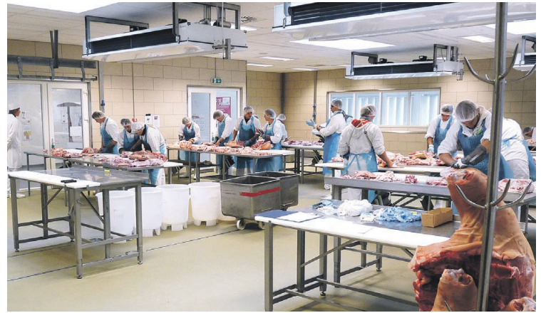
Im dänischen „Meat Trade College“ wurden Pichler Schlitzrinnen in massiver Industrieausführung installiert.
