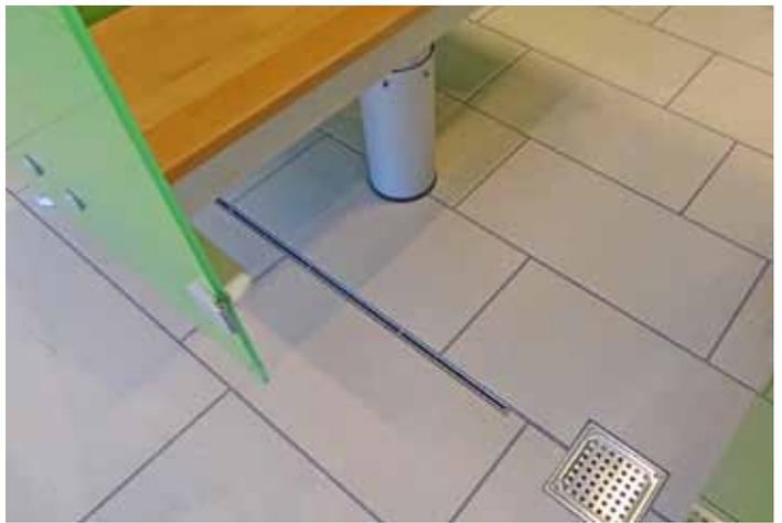
Unauffällig integriert sich die Linientwässerung im Duschbereich und den Umkleiden...
