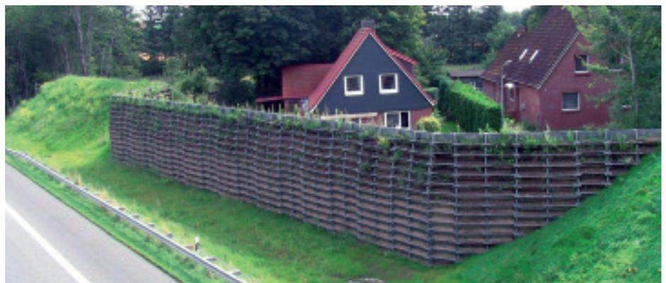
Bepflanzte Lärmschutzwände sind die schönste Form des Lärmschutzes. Mit der Gabionen-Bauweise wird das Lüft-System noch vielseitiger. | Fotos: Lüft
