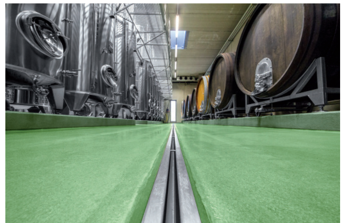
Das Weingut F.X. Pichler nutzt Schlitzrinnen mit Randverstärkung
