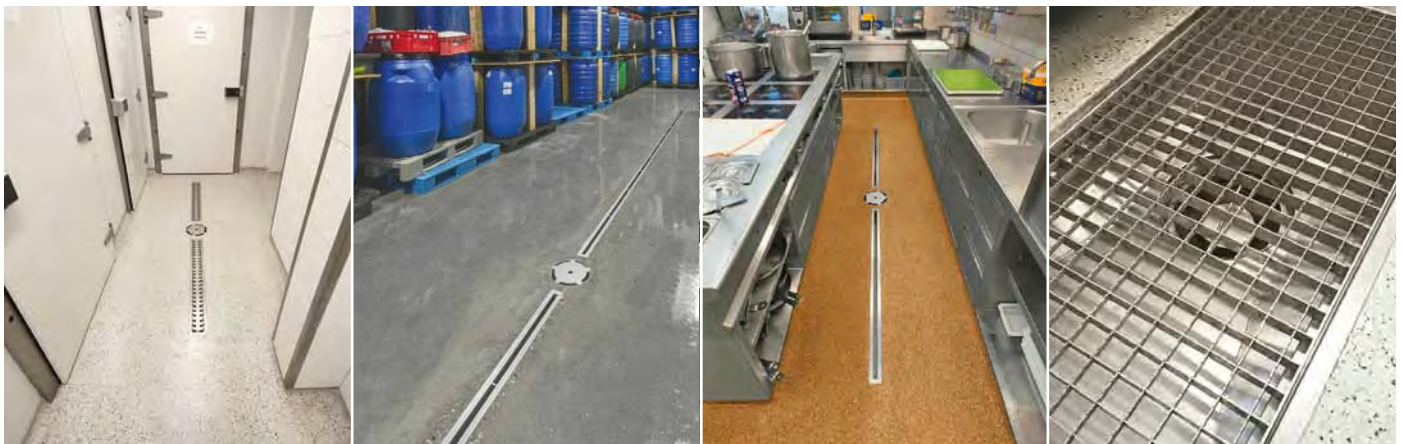
Praxisbeispiele für eine optisch ansprechende Linienentwässerung.
