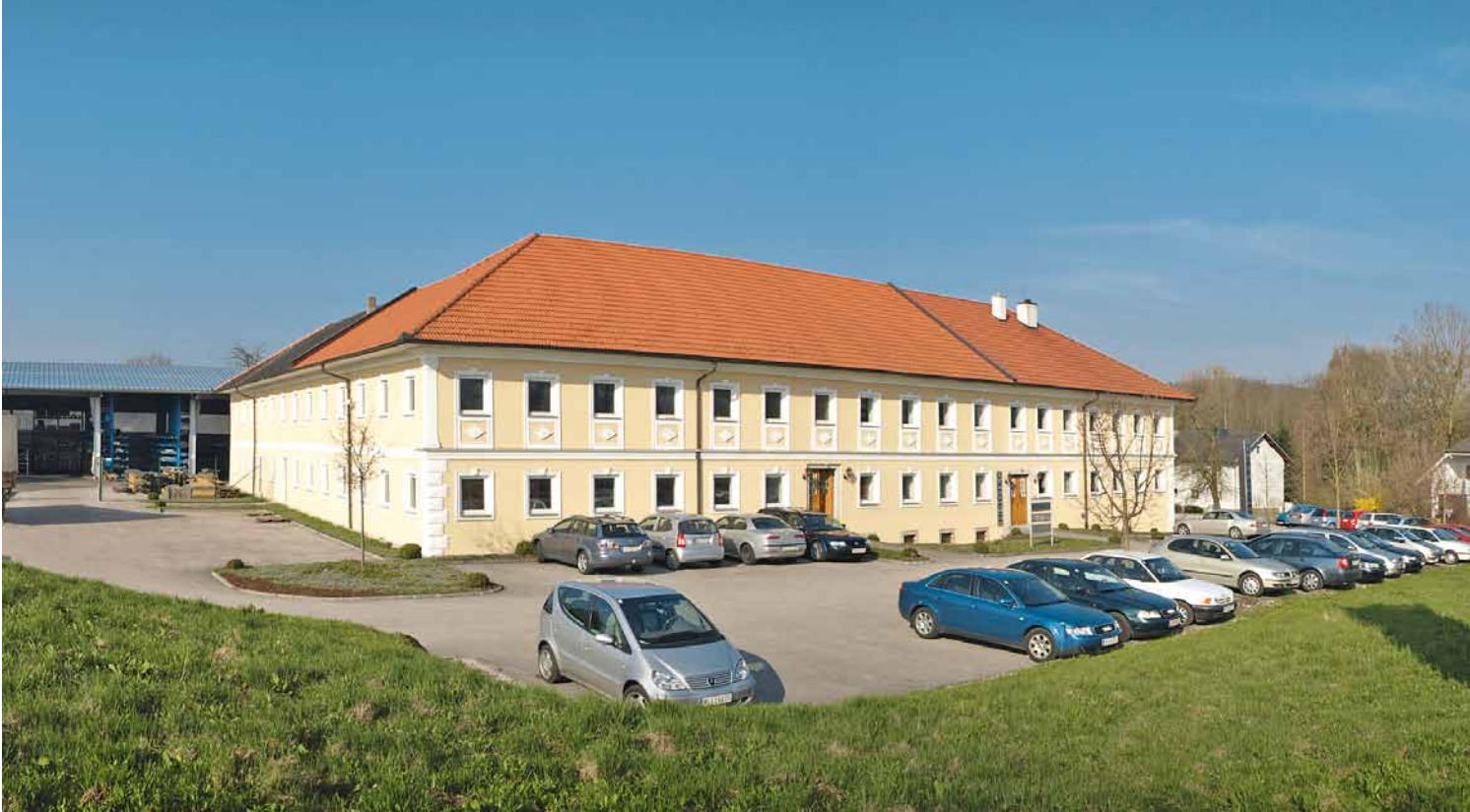
Die Firmenzentrale von Aschl in Pichl/Wels.
