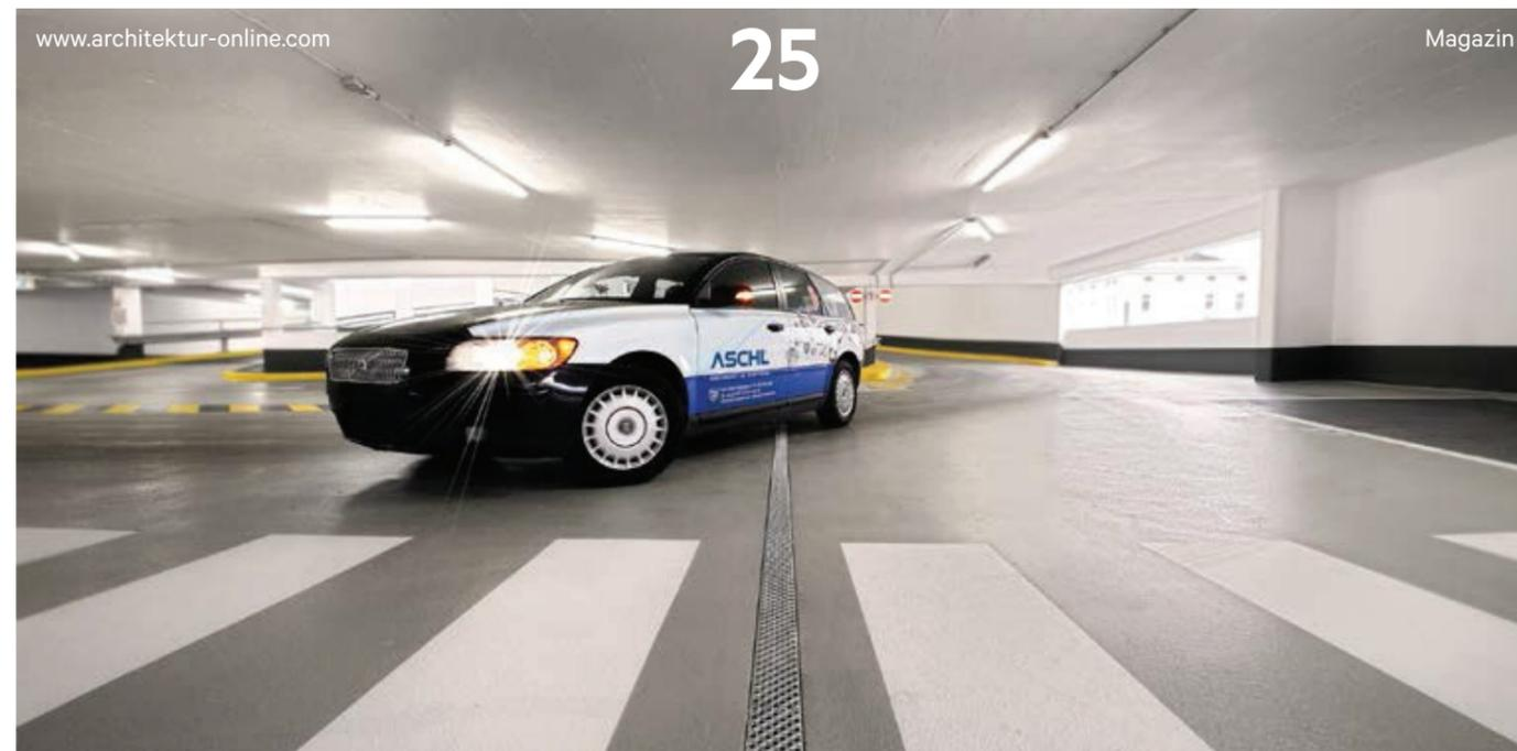
Die in Edelstahl gefertigte Parkdeckrinne wird standardmäßig in Längen von 500 bis 6000 und in Breiten von 100, 150 und 200 Millimetern produziert. Mit der geringen Höhe von nur 60 Millimetern ist sie auch für Sanierungen optimal. „Die Rinne kann schnell und exakt eingebaut werden. Durch die einfache, stufenlose Höhenjustierung von oben wird sie exakt dem Niveau der Bodenschicht angepasst.“
