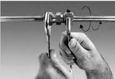
Direktmontage im Verschraubungsstutzen mit **ca. 1 1/4 bis 1 1/2 Umdrehungen** anziehen.
