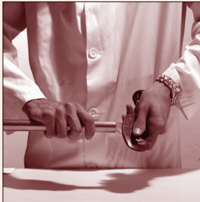
Fig. 22 | Entgraten der Rohrenden Pipe-end deburring
