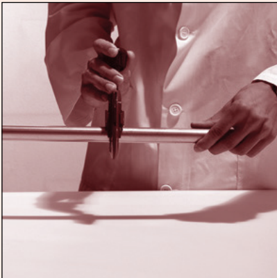
Fig. 21 | Schneiden der Rohre Pipe cutting
