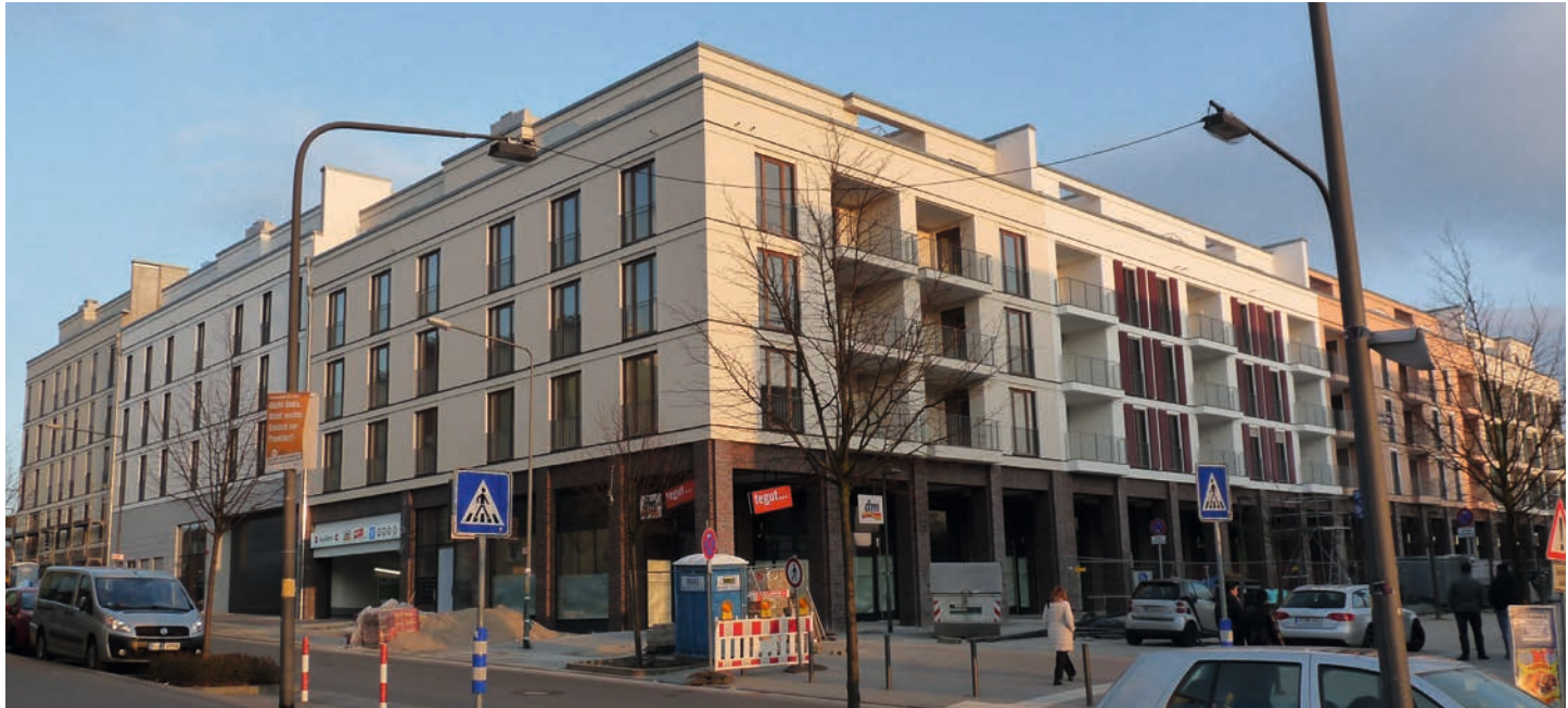
Parkhaus Gravensteiner Platz Frankfurt am Main, Hessen
