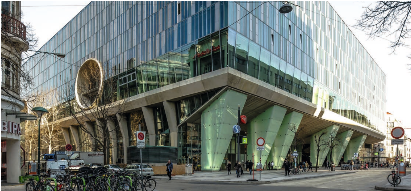
Parkhaus Wien-Mitte Wien
