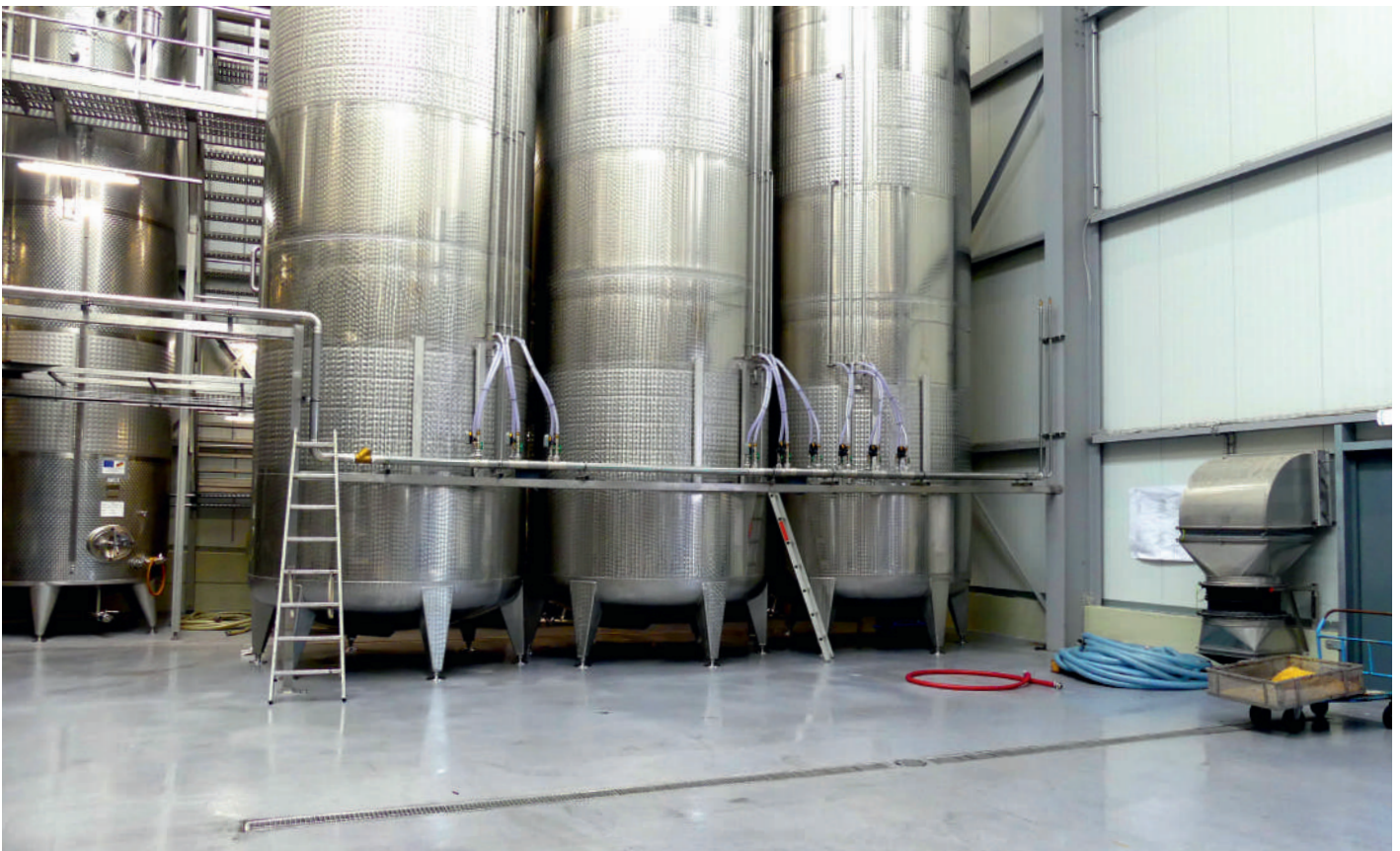
Kastenrinne Typ200 randverstärkt inkl. Stegrost und Bodenabläufe Eurosink Junior DN100 senkrecht, mit zwei gegenüberliegenden Rinnenanschlüssen, 13 Entwässerungslinien im neuen Tanklager der Moselland eG Winzer-genossenschaft.
